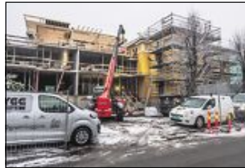
FORTSATT BYGGEPLASS: Tilbygget med fem leiligheter er under oppføring inntil Pay-villaen fra 1890.
